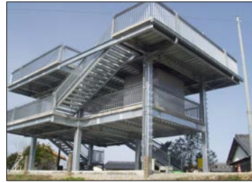
津波避難タワー 109/115箇所（95%）
