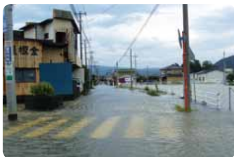
2007年/台風9号被害/沼津市大平地区(国土交通省沼津河川国道事務所)
