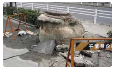
2011年／東日本大震災／浦安市高洲地区マンホール被害（消防科学総合センター）
