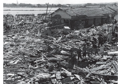
伊勢湾台風の被害状況 (写真提供：愛知県)
