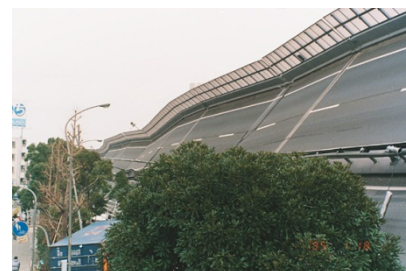
阪神高速道路の高架橋の倒壊 (写真提供：神戸市)
