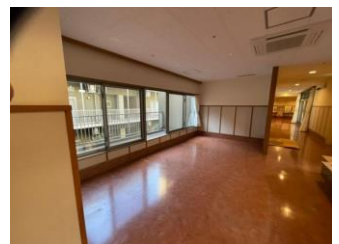
避難スペースを整備
