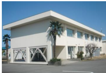
鉄骨造の耐震ブレースの設置
