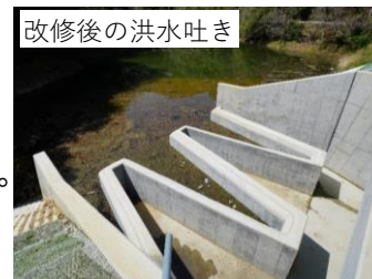
改修後の洪水吐き 洪水吐きの流下能力を12.5m³/sから45.5m³/sに3倍以上増強
