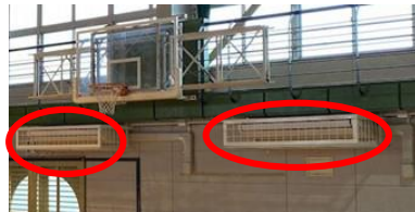
体育館への空調施設の設置
