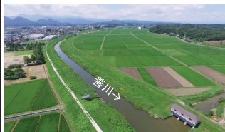
整備前(令和元年8月撮影)
