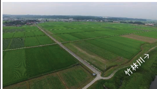
整備前(令和元年8月撮影)
