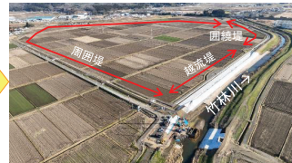
整備後(令和4年12月撮影)
