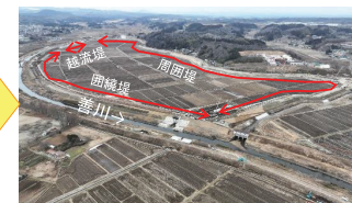
整備後(令和5年2月撮影)
