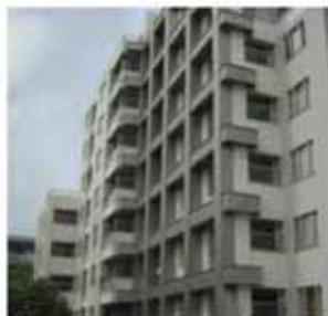
沿道建築物の耐震化(共同住宅)
