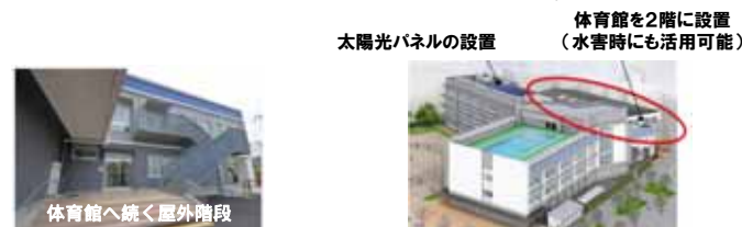
水害対策を踏まえた施設整備(東京都葛飾区立東金町小学校:令和4年8月竣工)
