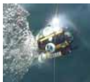
水中ロボットによるダム水中部の点検
