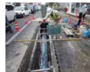
上水道基幹管路の耐震化(高知県高知市)
