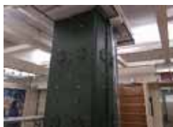
柱の改修による地下街の耐震性の向上
