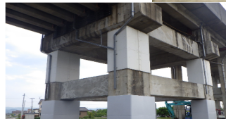
鋼板巻きによるラーメン橋台の耐震対策
