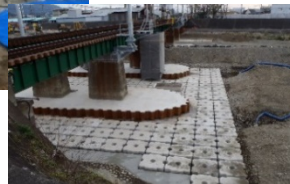
鉄道橋梁の流失・傾斜対策
