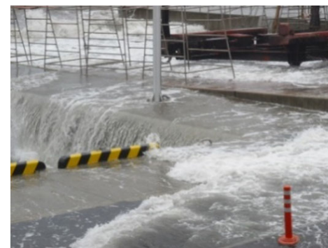
越波による浸水(平成23年台風12号)
