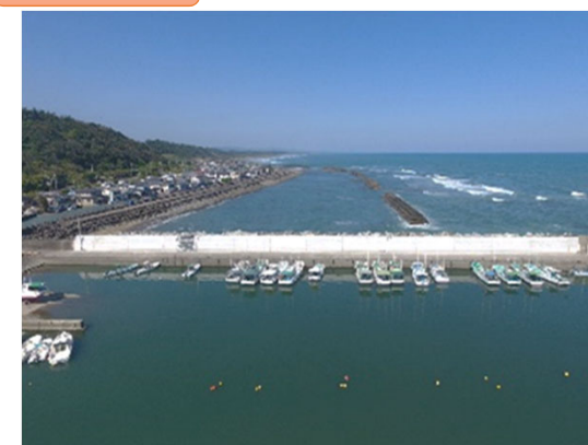
北防波護岸(改良、かさ上げ)
