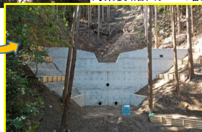
対策後(治山ダムの設置)
