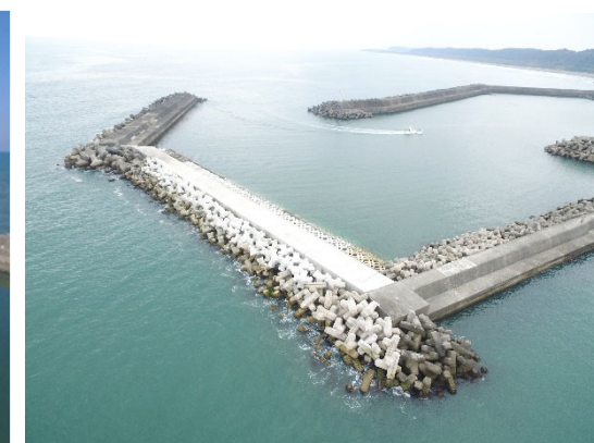
防波堤(新設、粘り強い化)
