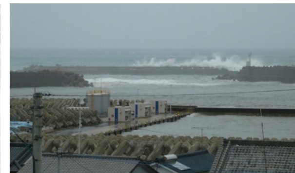
港内へ高波の進入
