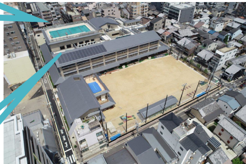
防災機能を備えた校舎
