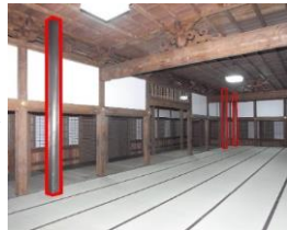
本堂内部(修理・補強後) 木カバー付きの鉄骨フレーム(赤囲み部分)による耐震補強を実施
