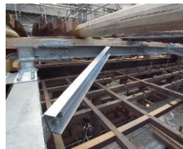
小屋内に組み込まれた鉄骨フレーム
