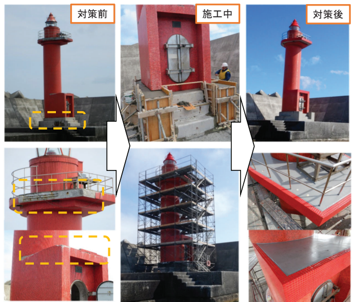
稚内港北副防波堤東灯台
