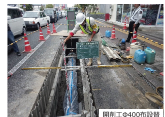
開削工Φ400布設替
