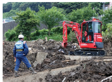
○重機で土砂排除【長野県大隊】
