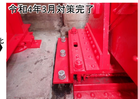
再塗装、アンカーボルトの設置
