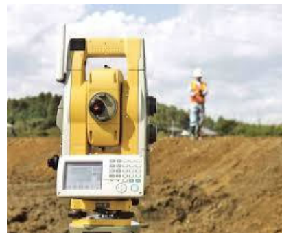
【トータルステーションの測量】
