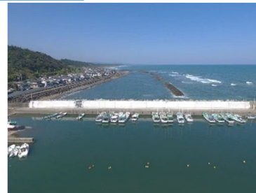
北防波堤護岸(改良)
