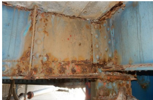
主桁の腐食
