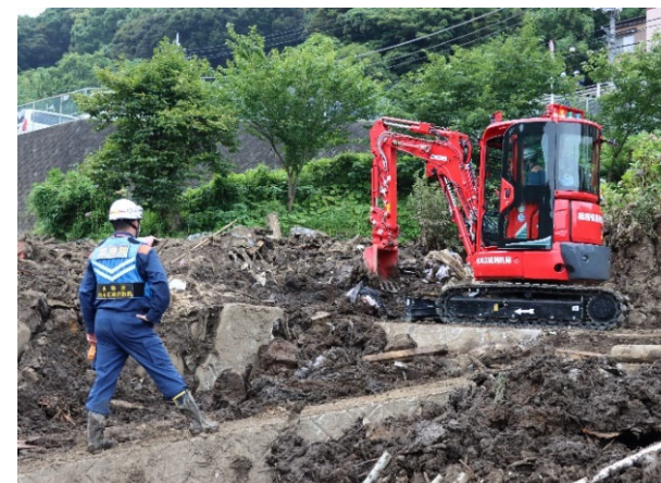
○重機で土砂排除【長野県大隊】
