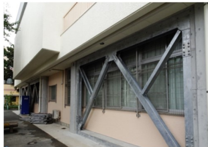
写真: 耐震補強工事後
