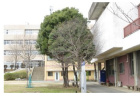
写真: 耐震補強工事前
