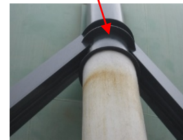
球形貯槽を支える脚部の補強対策
