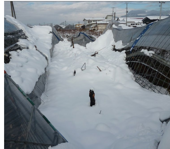
農業用ハウスの補強対策未実施
