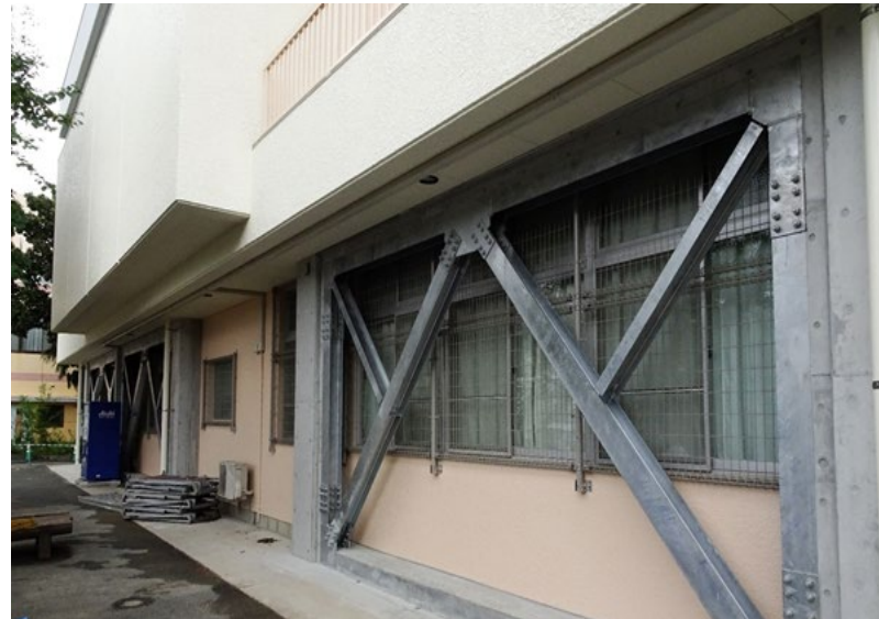
写真: 耐震補強工事後
