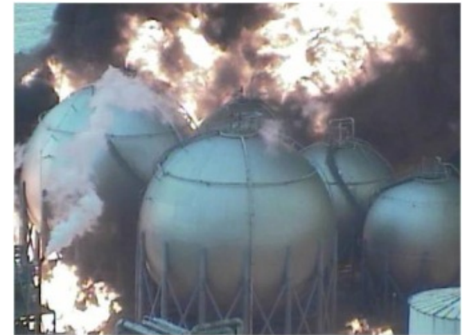
東日本大震災時に発生した大規模火災の様子
