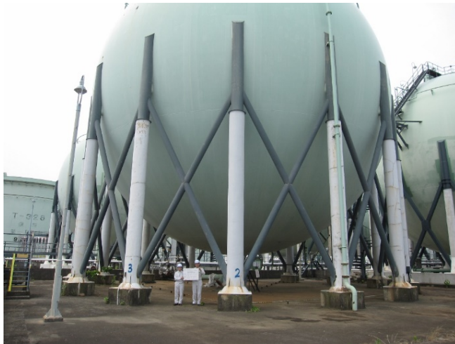
球形貯槽(耐震補強前)
