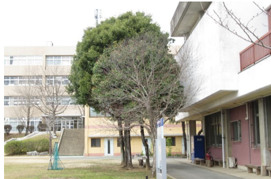
写真: 耐震補強工事前
