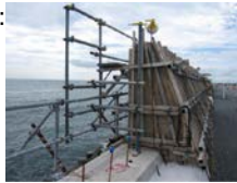
<既存護岸の嵩上げ>
