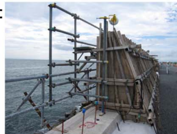
<既存護岸の嵩上げ>
