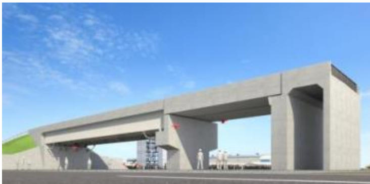
試験用橋梁【道路幅10m×50m×H5m】
