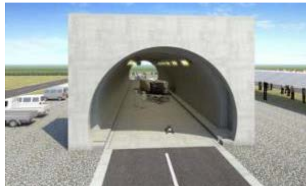
試験用トンネル【道路幅 6 m×50m】
