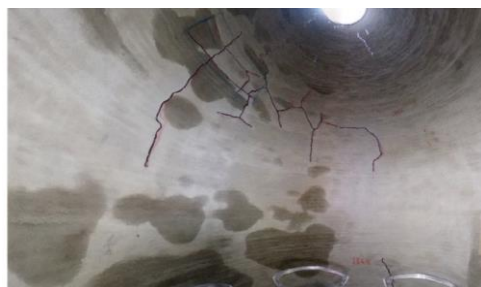
ドローン搭載カメラで撮影した画像
