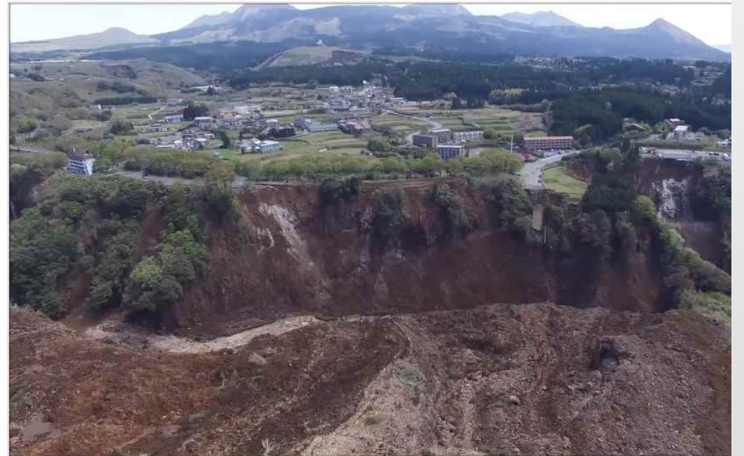
阿蘇大橋周辺(南阿蘇村立野)の土砂崩れ(出展：国土地理院)
