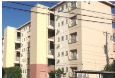
中層住棟へのエレベーター設置 (相模台団地/神奈川県)
