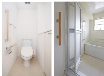
住戸内への手すりの設置
