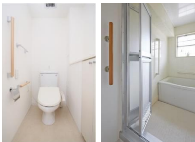
住戸内への手すりの設置
