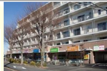
医療・介護施設等を併設したサービス付高齢者向け住宅の誘致 (豊四季台団地/千葉県)
