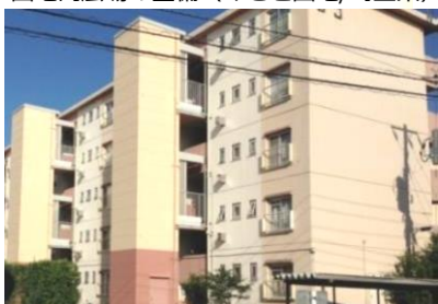
中層住棟へのエレベーター設置 (相模台団地/神奈川県)
