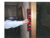
水平器による柱の傾きの計測
