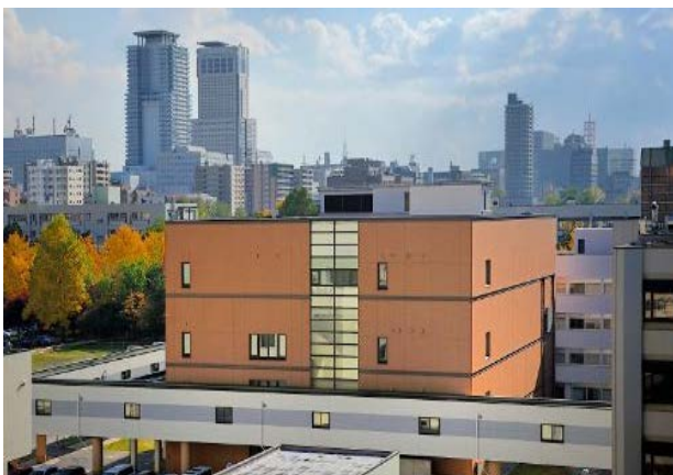
北海道大学病院 陽子線治療センター外観
