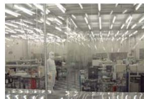
クリーンルーム
