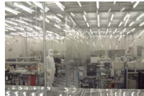
クリーンルーム
