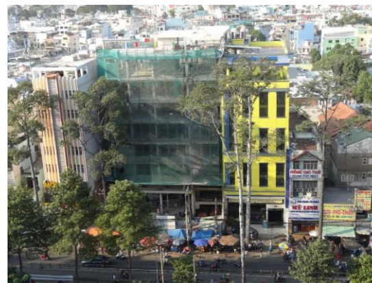
ベトナム 人間ドックセンター (建設状況)
