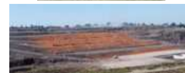
福岡方式の導入事例 （上：施工前、下：施工後）
