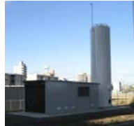
水素貯蔵タンク
