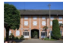
富岡製糸場東置繭所 （群馬県提供）
