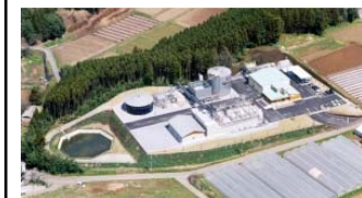
A市バイオマス資源化センター
