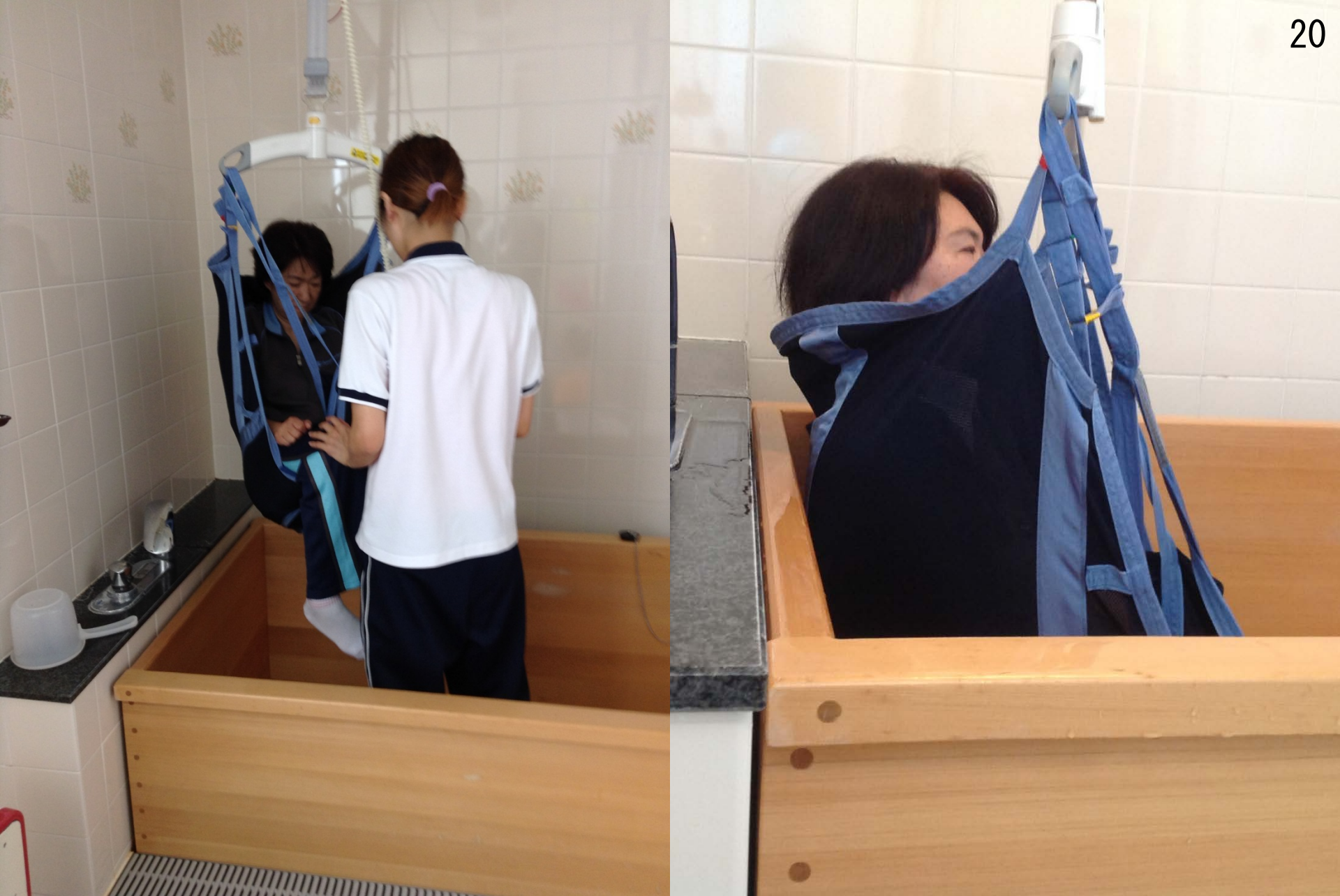
天井走行リフト(浴室内③)
