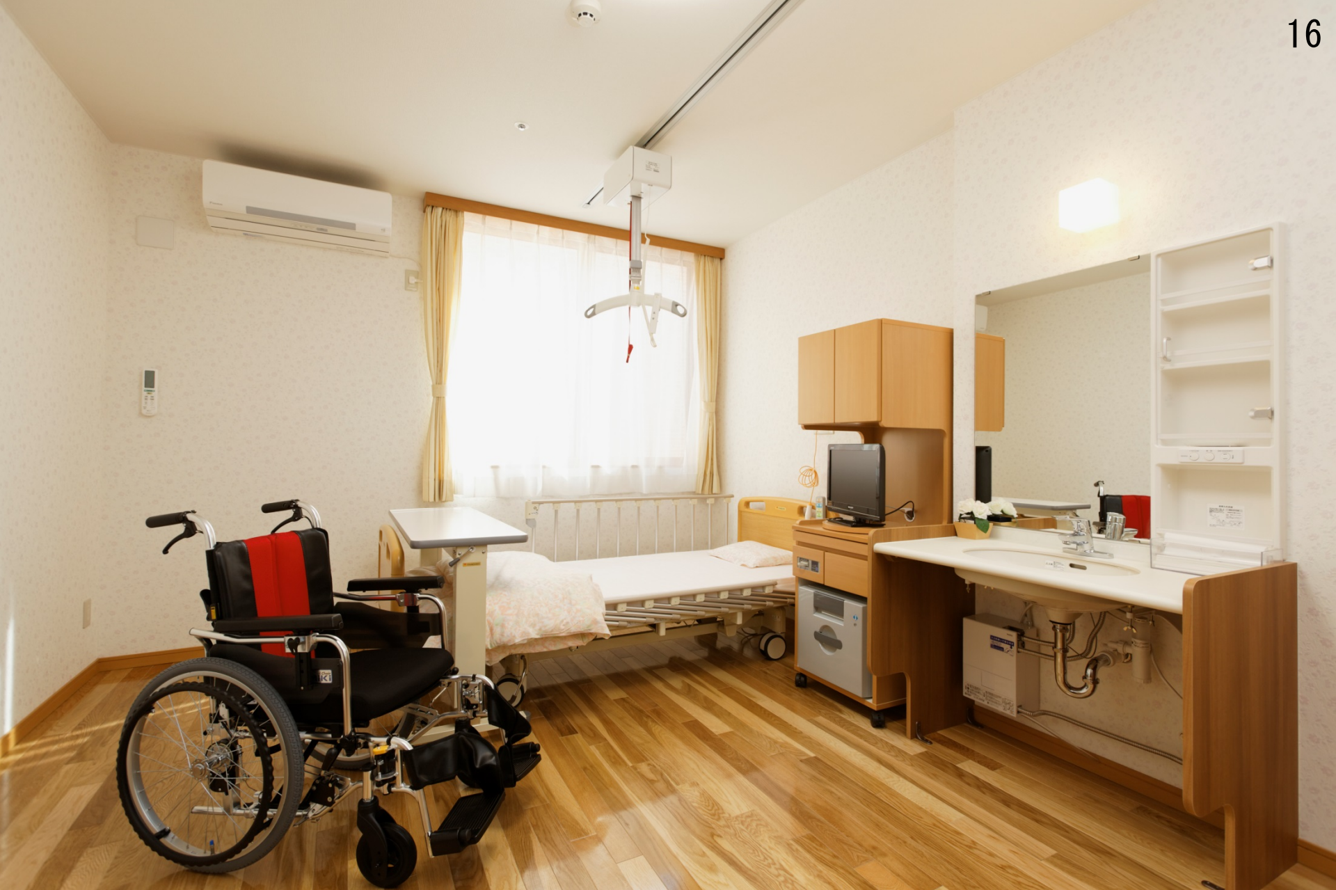
天井走行リフト(居室内)
