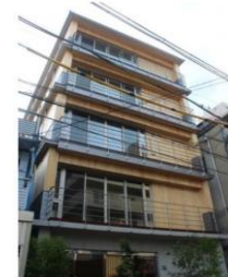
福祉施設（奈良県奈良市）
