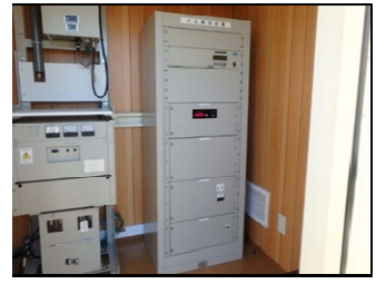
局舎内機器設置状況
