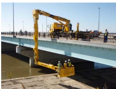
橋梁点検車による点検
