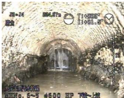
老朽管内部の例
