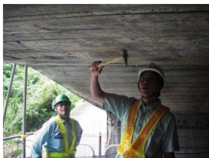
目視及びハンマーによる打音検査
