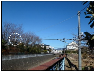
水位計設置状況
