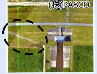
工事車両の影響で堤防沈下
