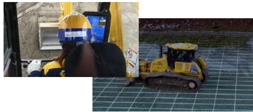
ICT建機による施工
