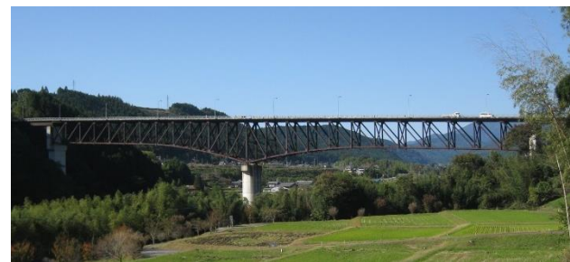
<乙姫大橋の状況>
