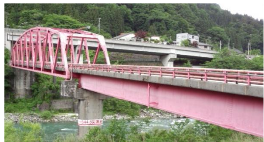
<音沢橋の状況>
