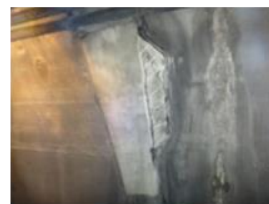
▲トンネル目地部
