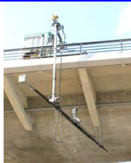
橋梁点検 カメラ システム
