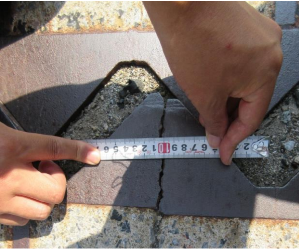
取替え後2年で、破断
