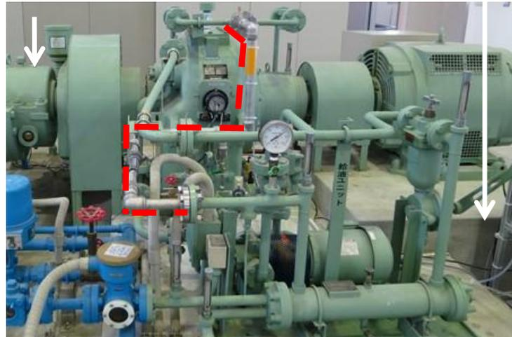
主ポンプ側 赤点線:取付け配管
