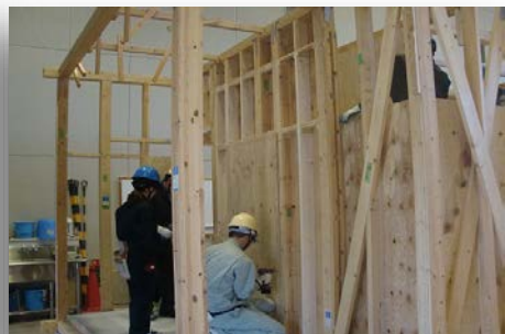
▲ 建築CADリフォームコース (構造部材組立加工実習)
