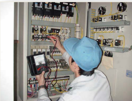
▲ 電気設備コース (制御盤製作実習)
