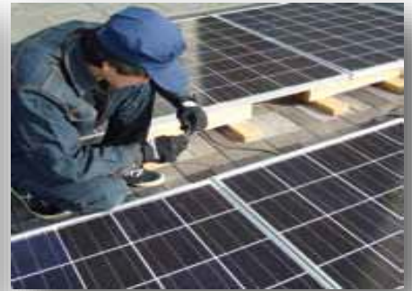
▲ 建築CAD・住環境コース (太陽光発電システム施工実習)
