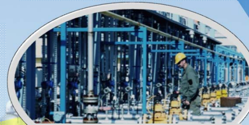
巡回点検 (日常保全)
