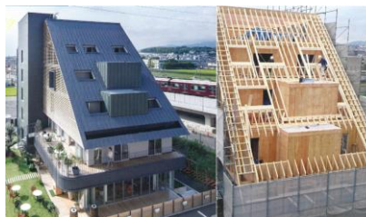
木造非住宅建築物 (※JAS構造材(2×4部材)を活用した商業ビル)
