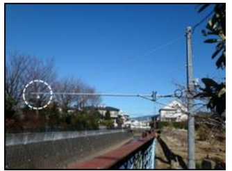
水位計設置状況
