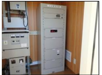
局舎内機器設置状況
