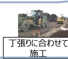
検測と施工を繰り返して整形
