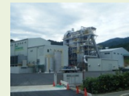
三重県の木質バイオマス発電施設 (11月から稼働)
