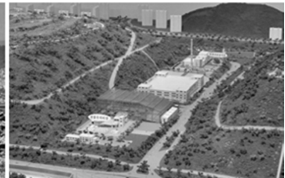
地下のメタンガス再利用施設
