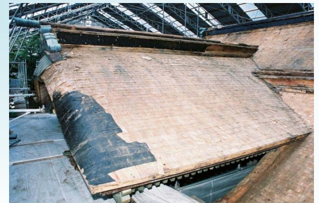
▲ 拝殿解体状況
