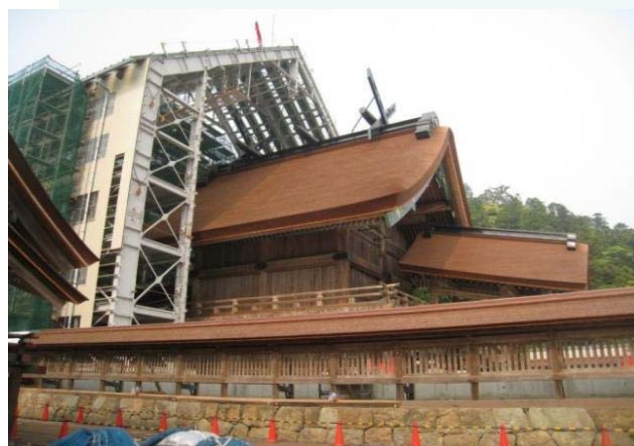
▲ 本殿 素屋根の解体
