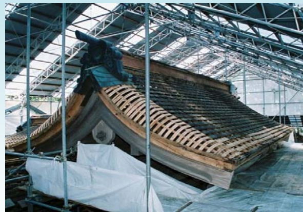
▲ 幣殿解体状況
