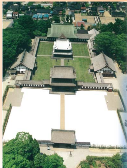
修理後（平成8年）
