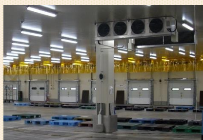
外気と遮断された買荷保管・積込所施設
