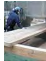
整備されたCLT生産施設
