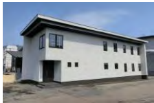
CLT建築物（北海道）
