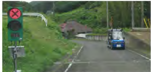
地域の協力を経て、一般車両が進入しないように簡易信号を設置し、専用区間を確保
