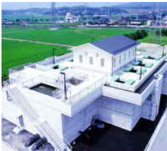
U-BCF 導入施設 (北九州市本城浄水場)
