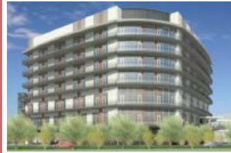
神戸国際フロンティアメディカル センター(2014年10月完成予定) (出典: 神戸市資料)
